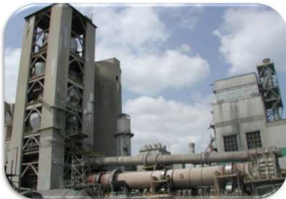
Слика 4.3 Ротациона пећ са четворостепеним циклонским предгрејачем
